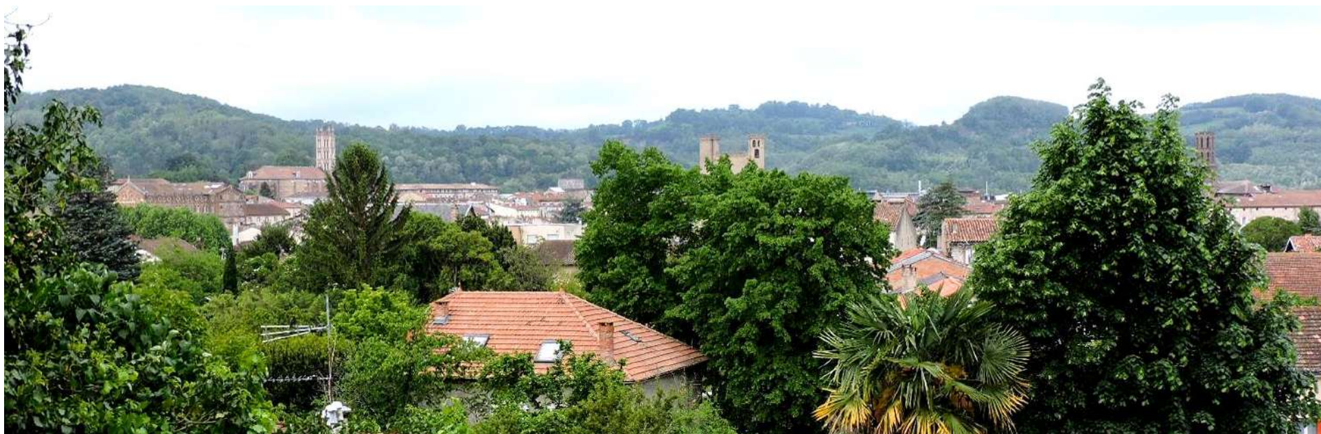
Pamiers dans son site, entre le rebord jardiné des terrasses de la plaine ariégeoise (lieu de la prise de vue) et au fond les reliefs du Terrefort.
