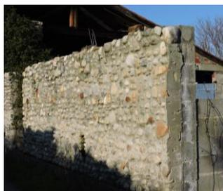
Exemple d'un mur de clôture en blocs de béton doublé d'une maçonnerie de galet reprenant une forme traditionnelle. Un mortier à la chaux et au sable ainsi qu'un plus grand soin apporté à la tranche du mur aurait permis une meilleure qualité architecturale.
