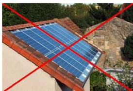
Il est vivement recommandé d'éviter les « cadres de tuile » et de regrouper les panneaux en un seul tenant sur un des côtés de la toiture en les faisant correspondre avec les arêtes de la toiture.
